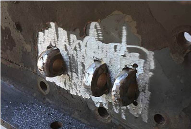
En saillie à travers l'autre coté, prêt à être soudé.
