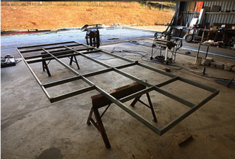
Le châssis terminé. Je dois toujours faire le support de roue, mais c'est tout ce que je peux faire tant que le camion n'est pas de retour.
