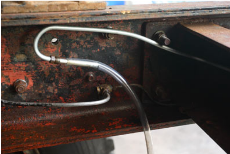
Tube PVC placé à l'extrémité de la canalisation neuve.
