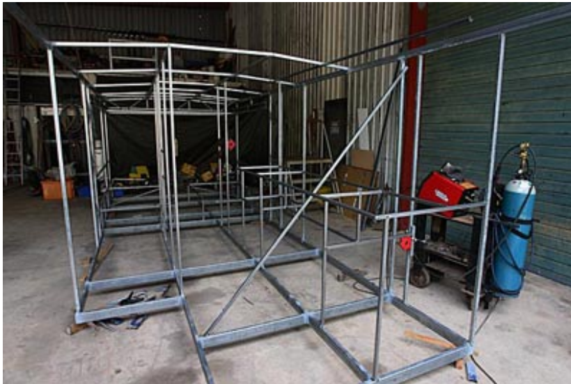
La structure avance. On voit le meuble de cuisine sur la droite.
