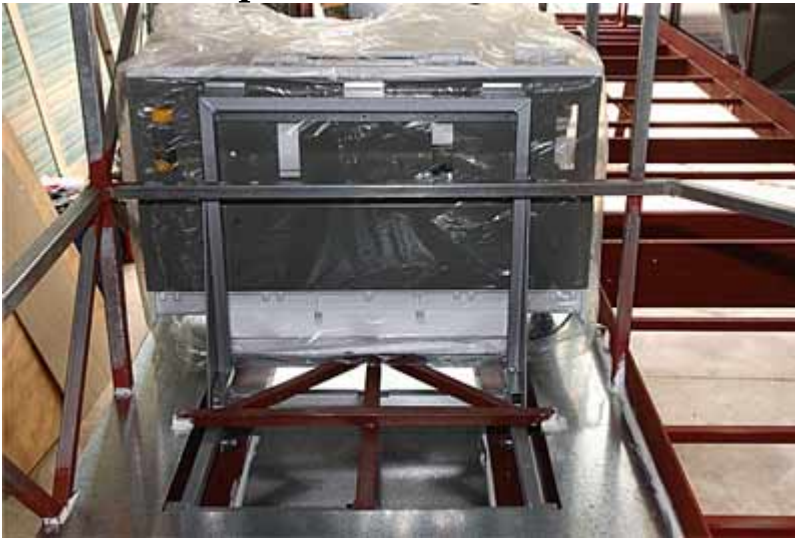
J'ai posé la tôle autour du mécanisme des toilettes.
