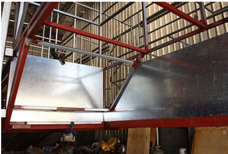
Le puits de roues de secours avec quelques unes des tôles en place.
